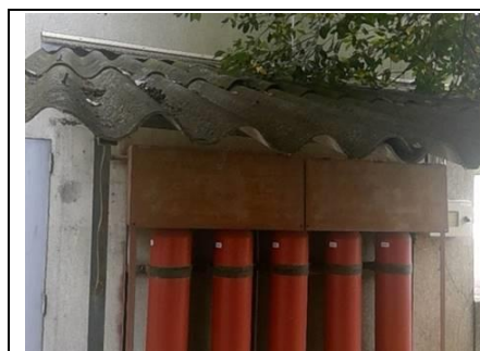
Photo n° PhA062 Localisation : Parties extérieures Ouvrage : Toitures Partie d'ouvrage : Plaques (fibres-ciment) Description : Plaques (fibres-ciment)
