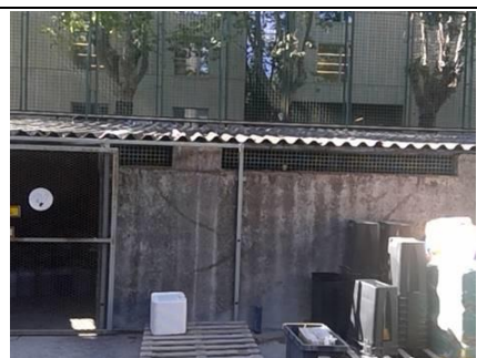
Photo n° PhA072 Localisation : Abris Ouvrage : Toitures Partie d'ouvrage : Plaques (fibres-ciment) Description : Plaques (fibres-ciment) Localisation sur croquis : M070
